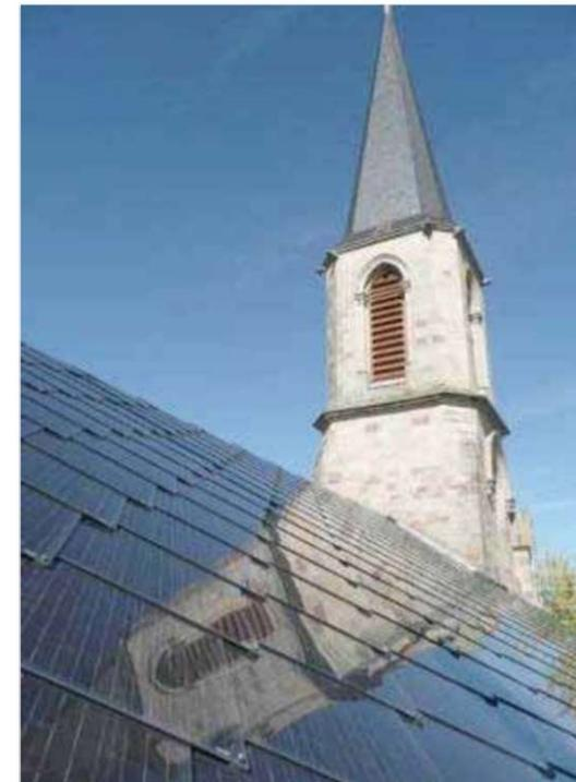
Figure 3 : Toiture de la nef de l'église de Manspach (68, Alsace), couverte au moyen de tuiles photovoltaïques, qui assurent également la fonction de couverture. Source : [www.saint-gobain-solar.com](http://www.saint-gobain-solar.com).
